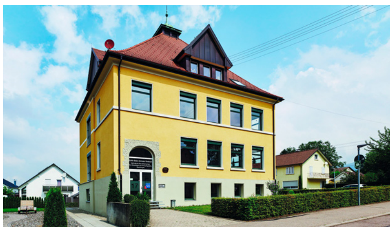
Das Schulgebäude in der Schulstraße 17 in Spaichingen
